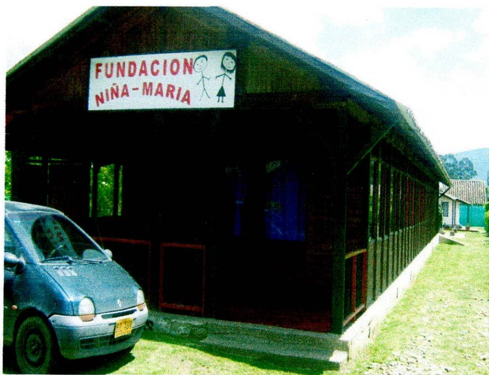
Fotografía. Instalaciones Fundación Niña María
