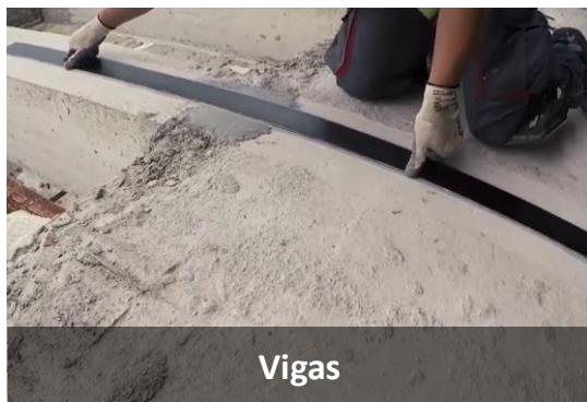
Vigas - Soporte Inferior
