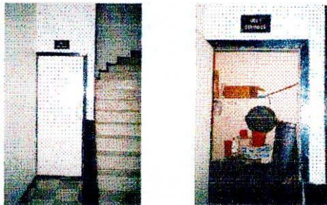
Figura 4. Depósito de desechos.
