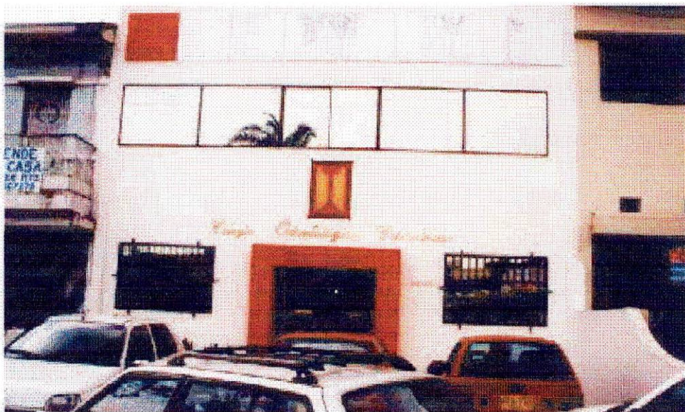
Ilustración 6. Nuevas Instalaciones para Prácticas Clínicas del C.O.C.
