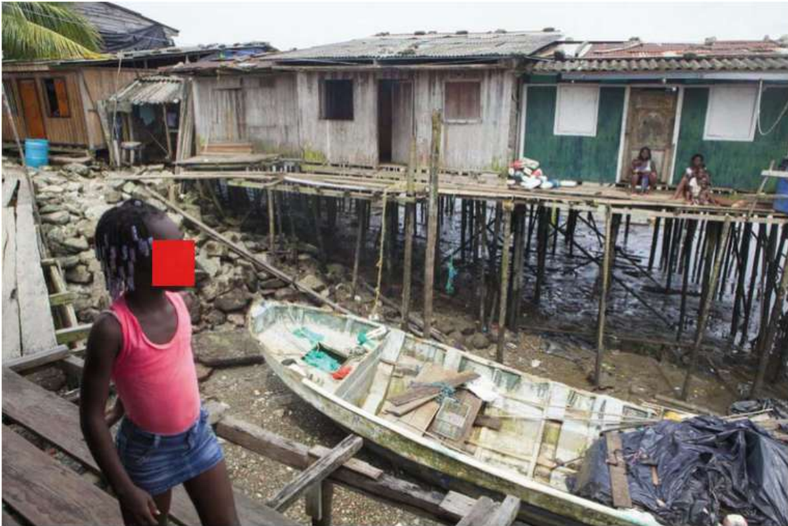
Figura 1. Fotografía viviendas palafíticas en Buenaventura, Valle del Cauca (Colombia)
